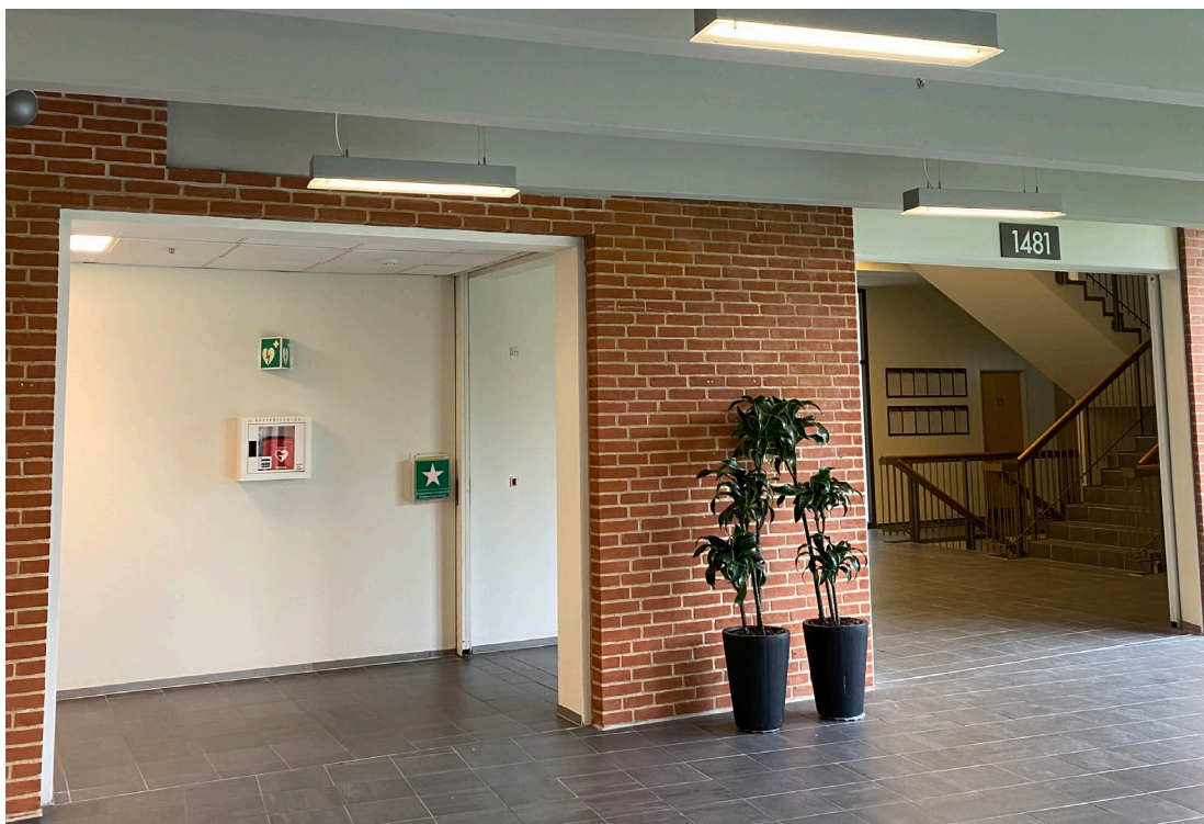
Findes på 2. etage mellem bygning 1482 og 1481
